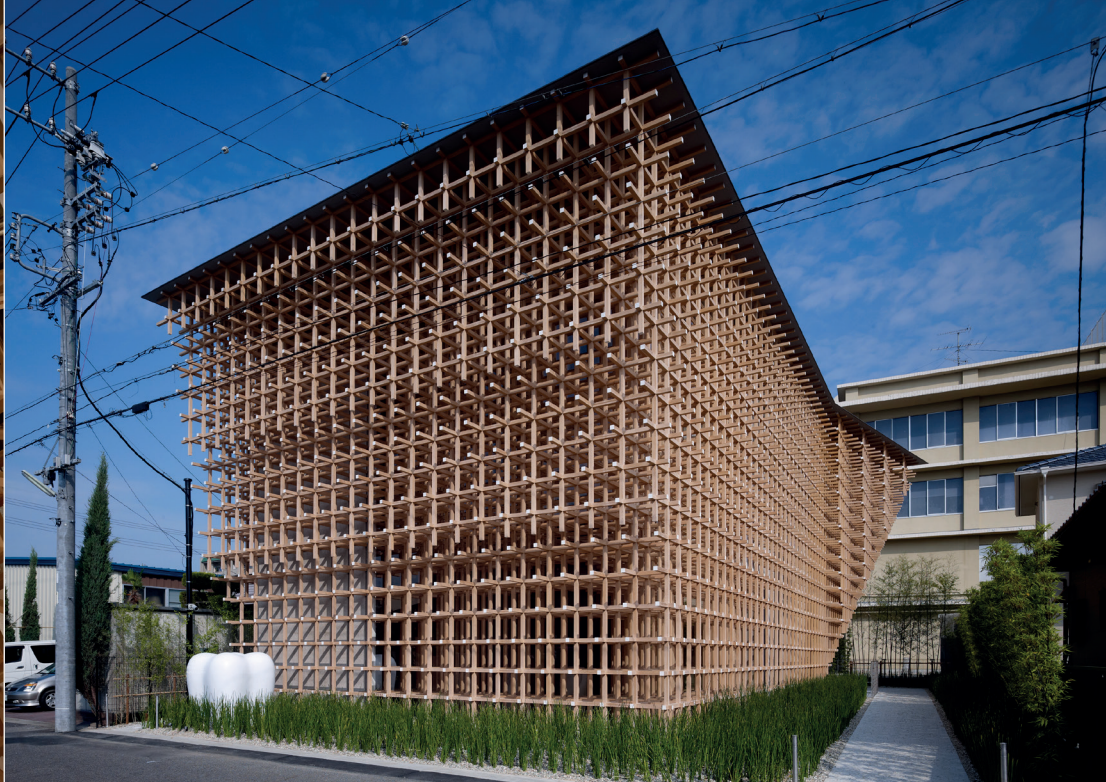
LA STRUCTURE repose sur le principe du Cidori, un ancien jeu composé de petits bâtons en bois de même taille THE STRUCTURE is based on the principle of Cidori, an ancient toy composed of small wooden sticks of the same size.
